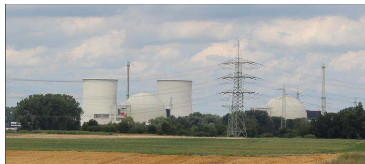
La centrale nucléaire de Biblis se trouve à environ 40 km de Darmstadt.
